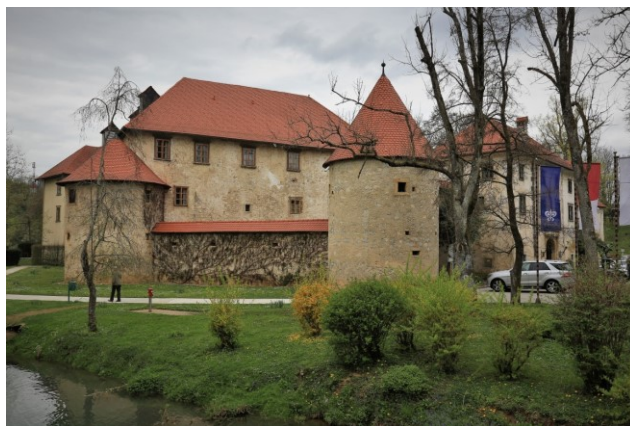
Grad na Otočcu je zdaj malo manj oblegan
